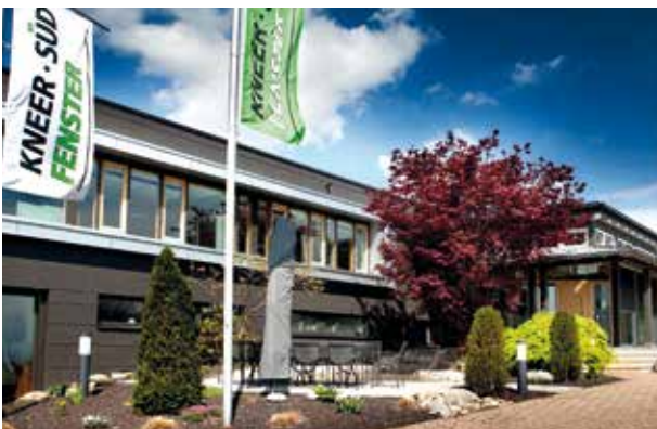
SÜD-FENSTERWERK in Schnelldorf
